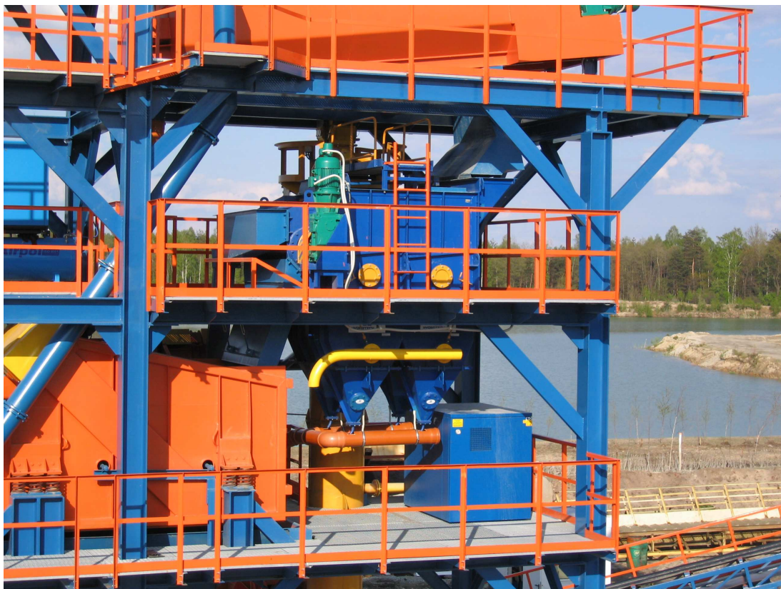
Rys.5. Widok osadzarki typu KOMAG w Żwirowni KSM Borzęcin
