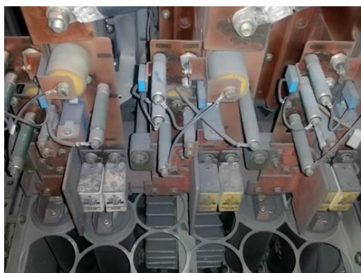
Rys. 6. Usuwanie zabrudzeń pochodzenia pyłowego z elementów wyposażenia elektrycznego – elementów elektronicznych, energoelektronicznych, styczników, elementów montażowych i ekranujących [10]
