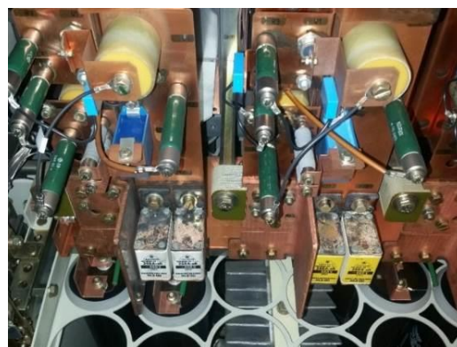
Rys. 6. Usuwanie zabrudzeń pochodzenia pyłowego z elementów wyposażenia elektrycznego – elementów elektronicznych, energoelektronicznych, styczników, elementów montażowych i ekranujących [10]
