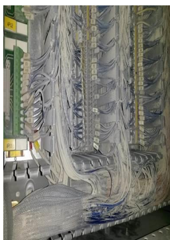
Rys. 6. Usuwanie zabrudzeń pochodzenia pyłowego z elementów wyposażenia elektrycznego – elementów elektronicznych, energoelektronicznych, styczników, elementów montażowych i ekranujących [10]
