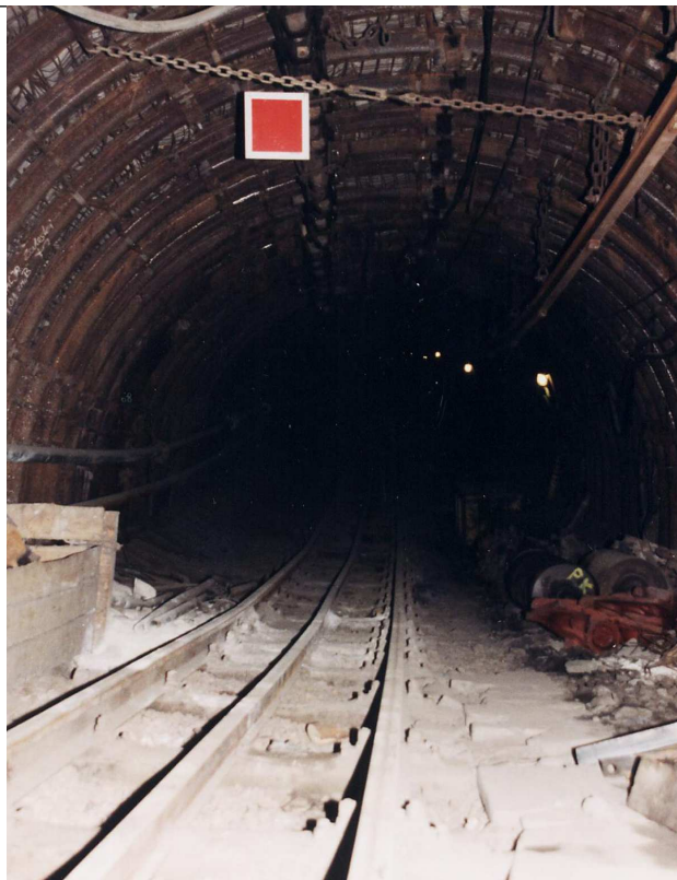
Rys.5. Pochylnia 5/1 z torowiskiem wyposażonym w trzecią szynę I120
