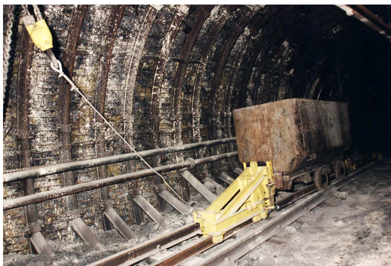
Rys.9. Przetaczanie wozów za pomocą kołowrotu pomocniczego
