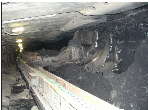
Rys.4. Widok ściany 10/II z obudową Glinik-15/32 POz
