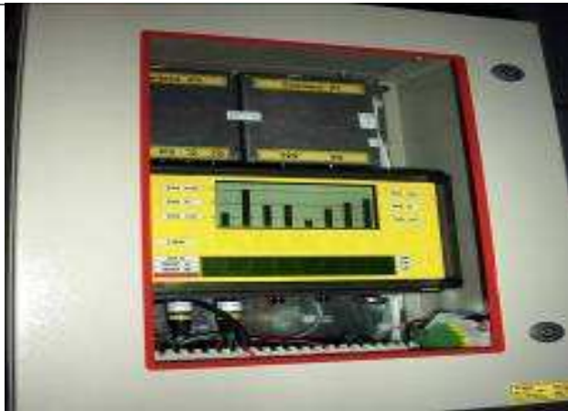
Rys.7. Wizualizacja poziomu sił w linach na stanowisku sterowania wciągarek ( F_{\text{śr}} +5\% ; F_{\text{śr}} ; F_{\text{śr}} -5\% )
