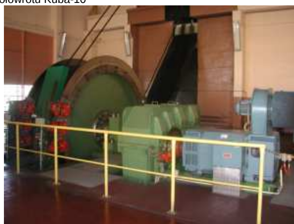
Rys.7. Maszyna wyciągowa 2L-4000
