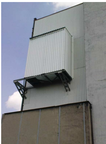
Rys.8. Tłumik hałasu czepni wentylatora promieniowego i rozkład pola akustycznego [11]: a) przed zabudową (rys. lewy), b) po zabudowie tłumika hałasu (rys. prawy) - widoczne ciemniejsze kolory (niższe poziomy dźwięku) w obszarze zabudowy chronionej
