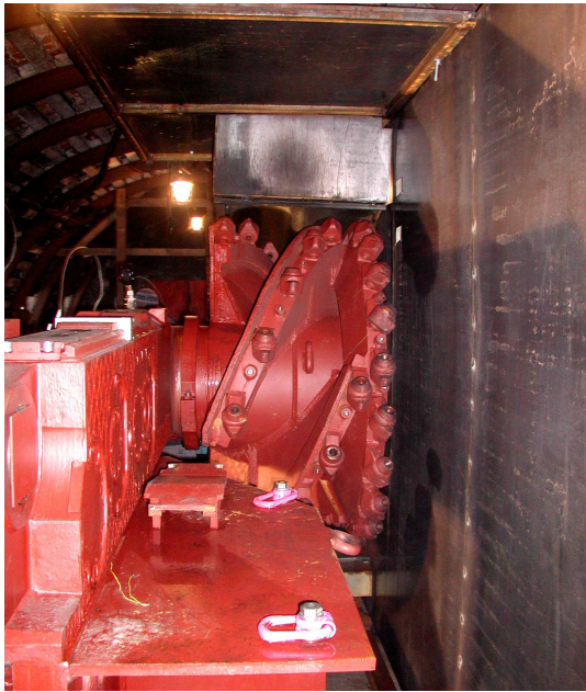
Rys.7. Ramię z instalacją zraszającą powietrzno-wodną i organem zabudowane na stanowisku badawczym w KD „Barbara”
