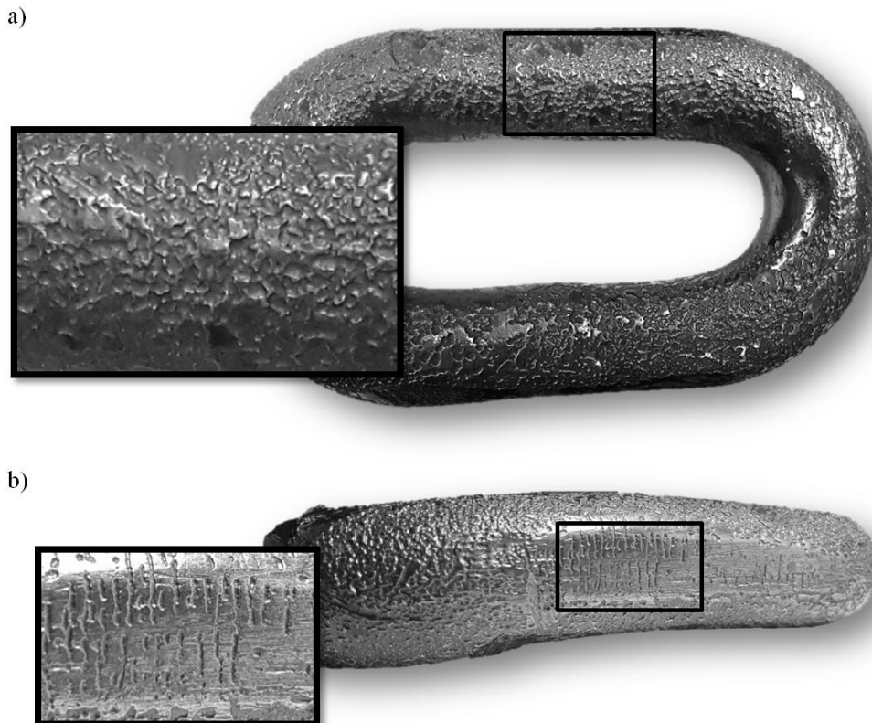
Rys. 6. Korozja ogniw łańcucha 34x126: a) obraz wżerów korozyjnych na powierzchni ogniwa łańcucha pracującego w środowisku silnie korozyjnym, b) obraz wzajemnego oddziaływania pęknięć na odcinku prostym ogniwa z postępującym niszczeniem korozyjnym [opracowanie własne]
