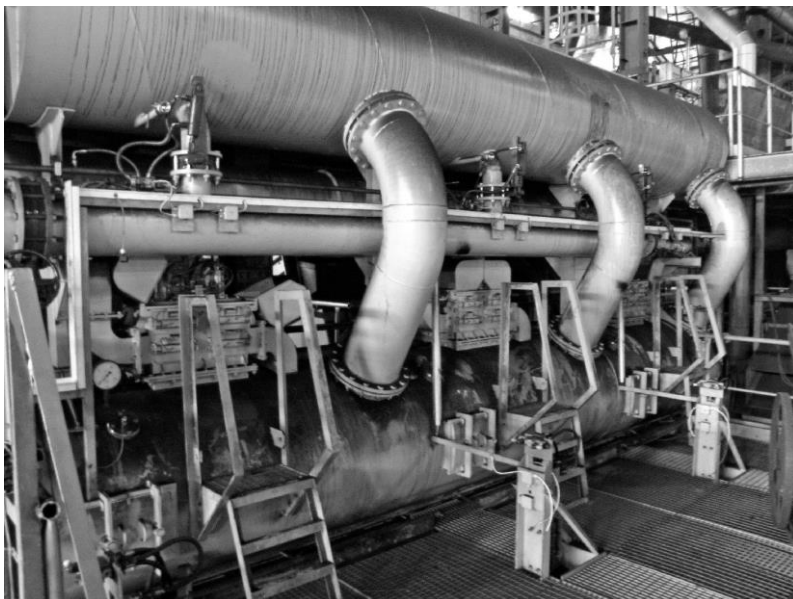
Rys.2. Widok osadzarki OM30 w KWK „Szczygłowice”
