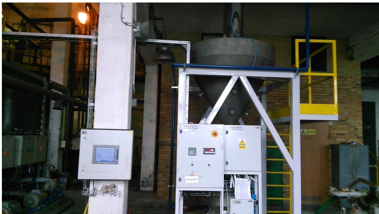
Rys. 5. Panel sterownia układu dozowania i transportu suchego flokulanta [źródło: pozycja literaturowa nr 4]
