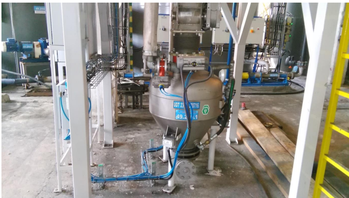
Rys. 3. Podajnik komorowy suchego flokulanta [źródło: pozycja literaturowa nr 4]
