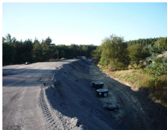
Rys. 1, 2 – Budowa obwodnicy Chrzanowa z zastosowaniem kruszyw z Zakładu Górniczego Sobieski w fazie rozpoczęcia oraz w fazie wybudowania części nasypu drogi (źródło [8])
