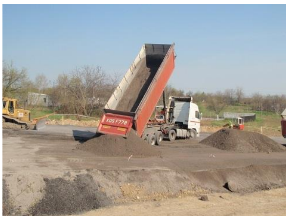
Rys. 1, 2 – Budowa obwodnicy Chrzanowa z zastosowaniem kruszyw z Zakładu Górniczego Sobieski w fazie rozpoczęcia oraz w fazie wybudowania części nasypu drogi (źródło [8])
