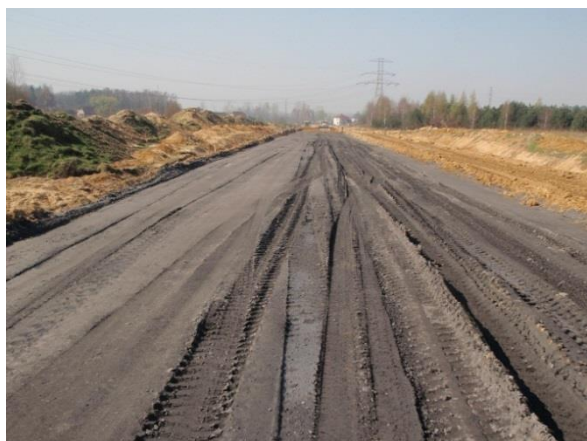
Rys. 5 – Budowa drogi ul. Orłąt Lwowskich w Jaworznie z zastosowaniem kruszyw z Zakładu Górniczego Sobieski w fazie budowy nasypu oraz po zakończeniu budowy (źródło [8])
