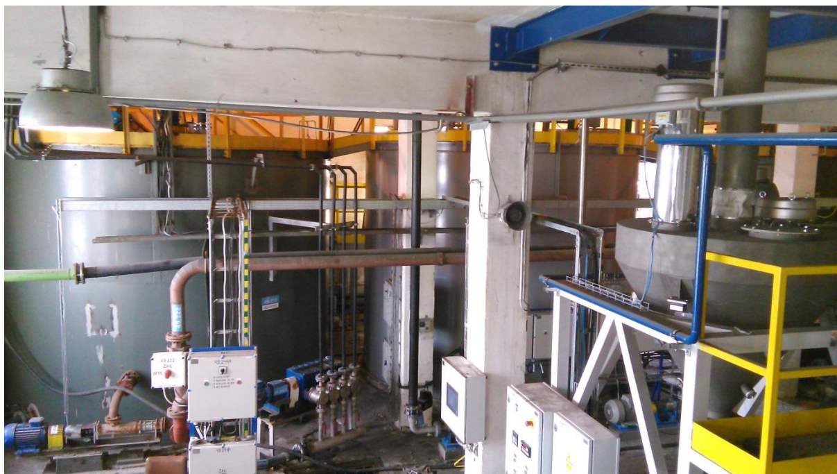
Rys. 6. Zbiorniki ciekłego flokulanta i zbiornik buforowy suchego flokulanta [źródło: pozycja literaturowa nr 4]
