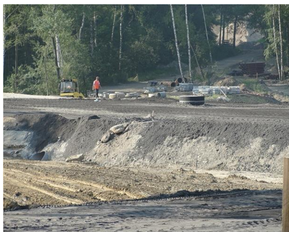
Rys. 3, 4 – Budowa drogi ul. Orłąt Lwowskich w Jaworznie z zastosowaniem kruszyw z Zakładu Górniczego Sobieski w fazie budowy nasypu oraz po zakończeniu budowy (źródło [8])
