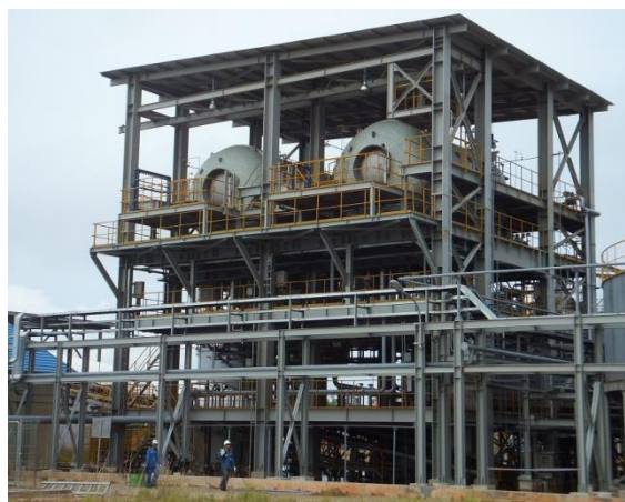
Rys. 2. Filtry tarczowe HiBar (70 m 2 każdy) z kabinami parowymi do filtracji parowo-ciśnieniowej (po lewej); budynek filtrów z dwoma filtrami tarczowymi HiBar o pow. 70 m 2 każdy (po prawej)
