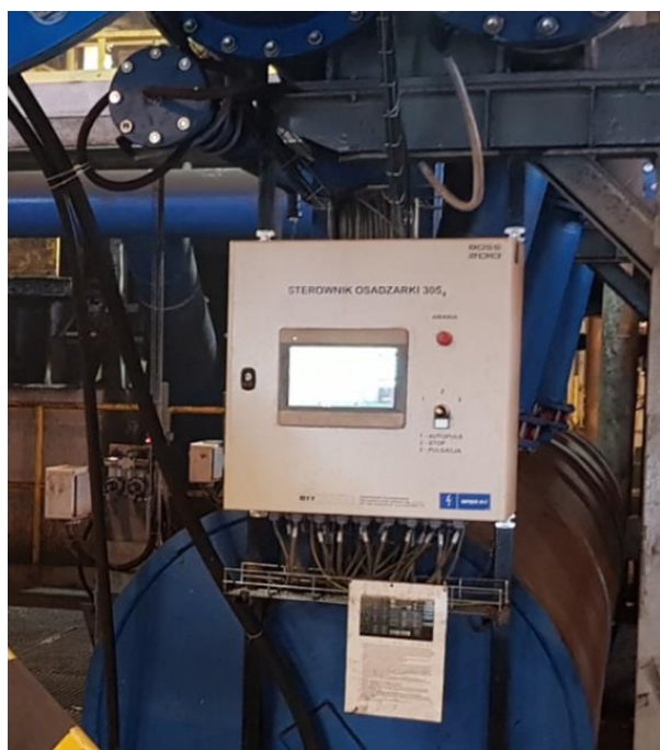
Rys. 3. Zabudowany sterownik osadzarki [źródło: opracowanie własne]
