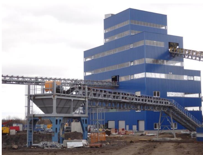
Rys. 1. Zakład przeróbki odpadów pogórnich Heřmanicka Hałda Ostrawa
