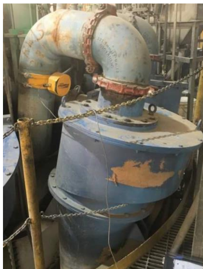
Rys. 8. Czujnik rurociągu przelewowego [10]
