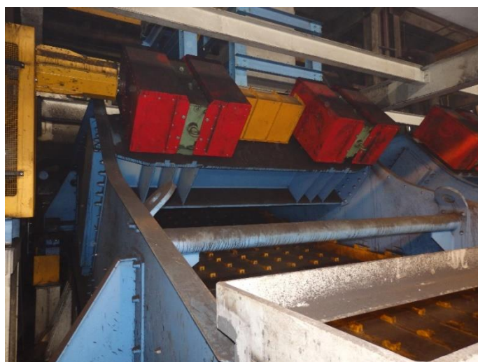
Rys.1b. Przesiewacz wibracyjny PWP1-1Z-2,8 x 6,0 – zdjęcie z instalacji
