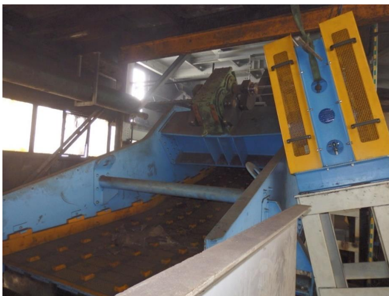
Rys. 2a. Przesiewacz wibracyjny PWP1- 2,4 x 6,0 – zdjęcie z instalacji
