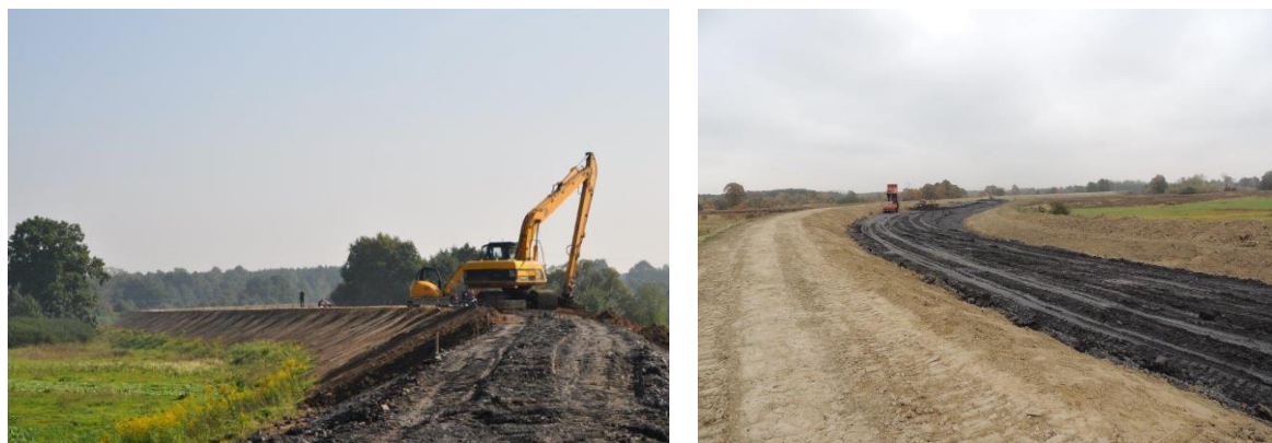
Rys. 12. Budowa wałów przeciwpowodziowych w okolicach Oświęcimia
