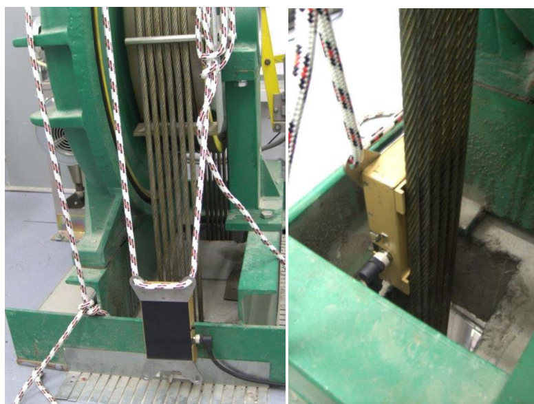
Rys. 4. Obiekt pomiarowy – liny nośne dźwigu osobowego w szybie Regis, badanie przy użyciu głowicy magnetycznej
