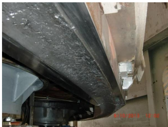
Rys. 5. Uszkodzenie bieżni nadwozia
