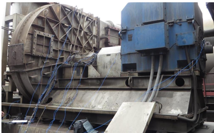
Rys. 7. Badania drgań wentylatora z wykorzystaniem czujników do pomiaru przyspieszeń drgań [37]
